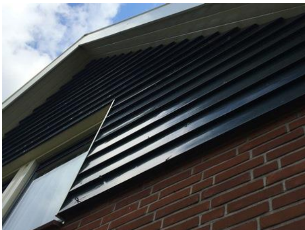
De houten topgevel vormt geen potentiële verblijfplaats voor vleermuizen omdat de holle ruimte achter de planken niet bereikbaar is.
