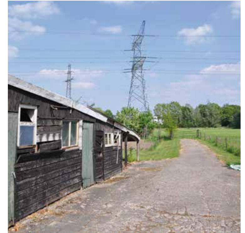
Schuren en verharding zijn in de loop van de tijd verwaarloosd geraakt
