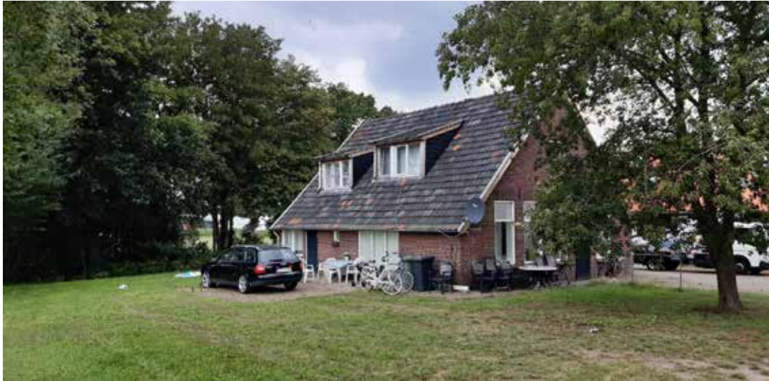
De te slopen woning en de omliggende tuin.
