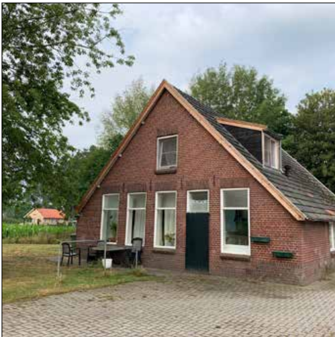
te slopen boerderij op het erf aan de Rondweg 42
