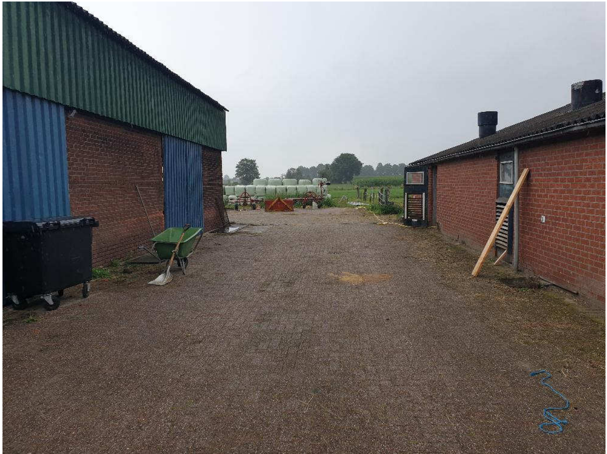
Foto locatie inspectiegaten 304 en 305
