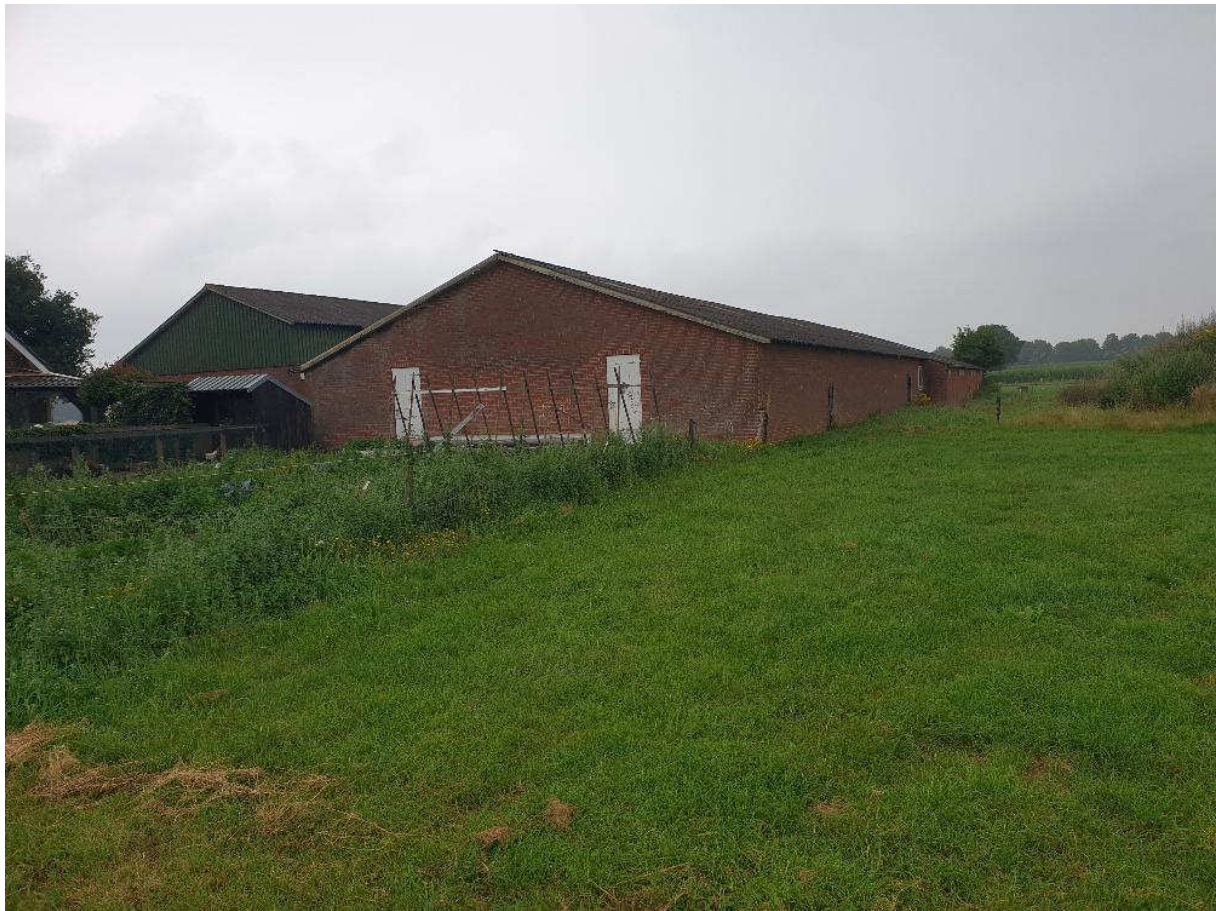
Foto locatie inspectiegaten 201 t/m 204
