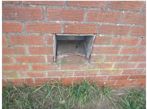
inspectie afwerking ventilatie
