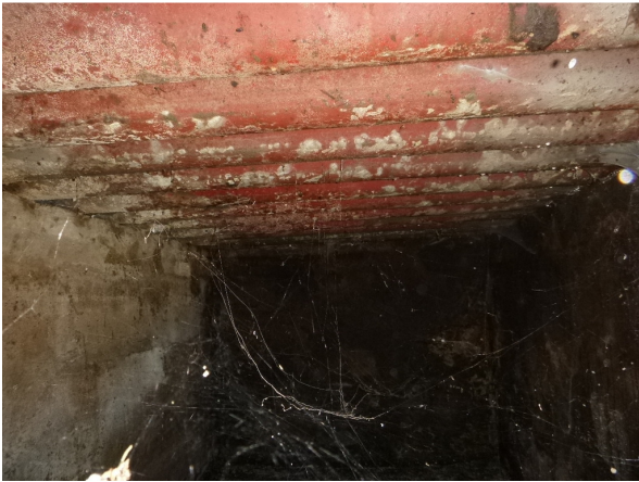
verloren bekisting in mestkelders schuur 5 (asbesthoudend)
