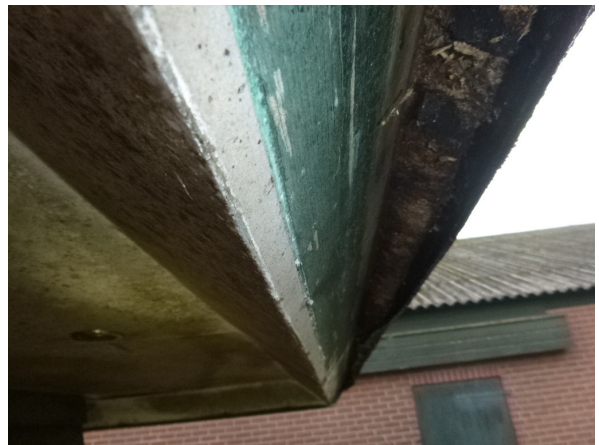
inspectie oversteek schuur 1
