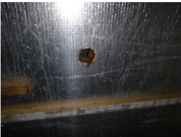
isolatieplaten binnenkant dak
