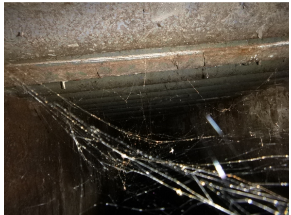
inspectie in mestkelder (verloren bekisting) schuur 5
