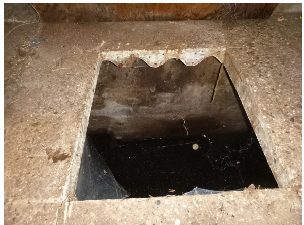
gezaagde uitsparing in vloer (verloren bekisting schuur 5)
