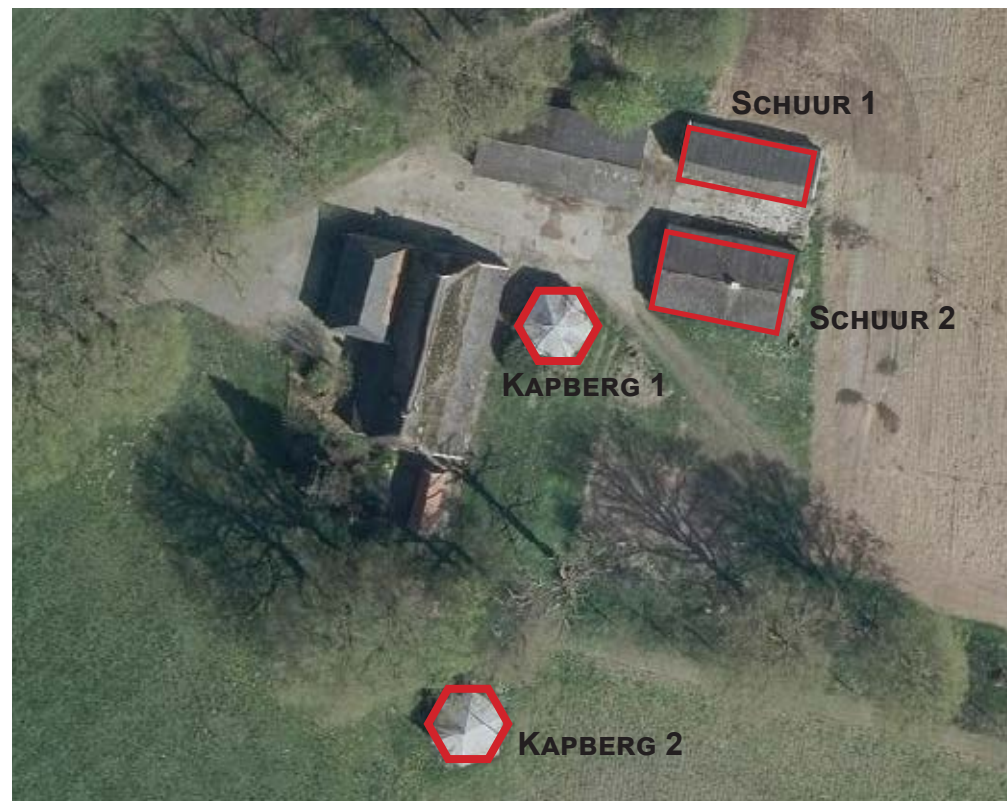
Figuur 13. Overzicht te slopen opstallen Rijssensestraat 107
