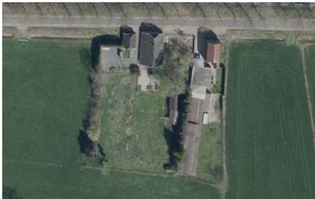
Figuur 3. Luchtfoto van het erf - alle schuren en woningen worden gesloopt
