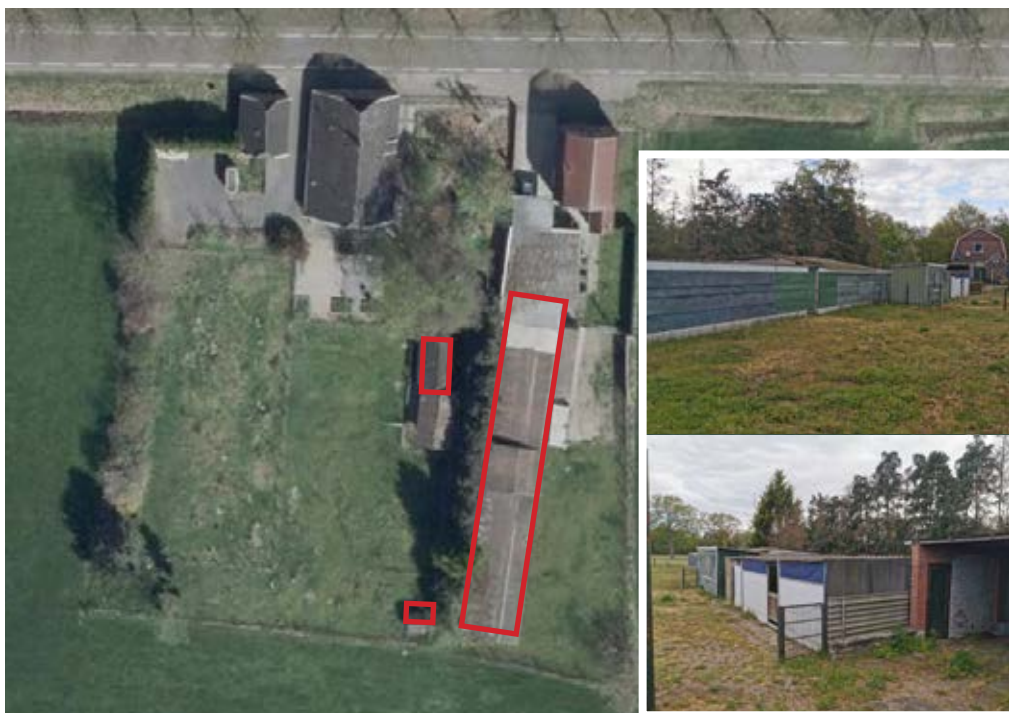
Figuur 12. Overzicht te slopen opstallen Nijverdalsestraat 137 - 139
