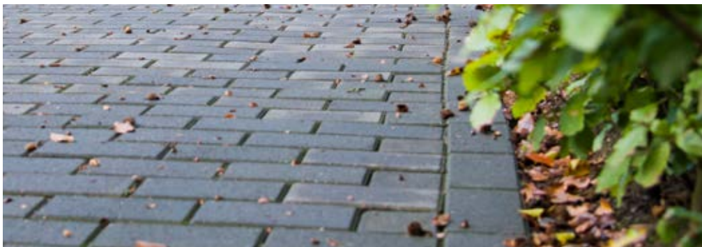
Figuur 16. Ontsluitingsweg wordt voorzien van klinkerverharding.
