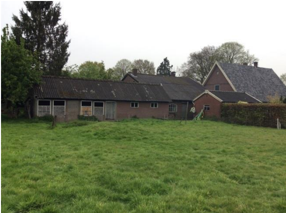
Figuur 8: Overzichtsfoto bebouwing
