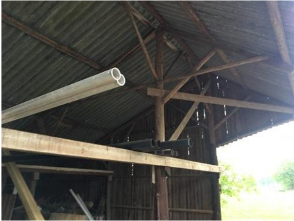
Detailopname van de te slopen kapschuur; in deze schuur ontbreken potentiële verblijfplaatsen van vleermuizen.
