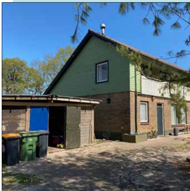
bestaande bedrijfswoning wordt opgeknapt
