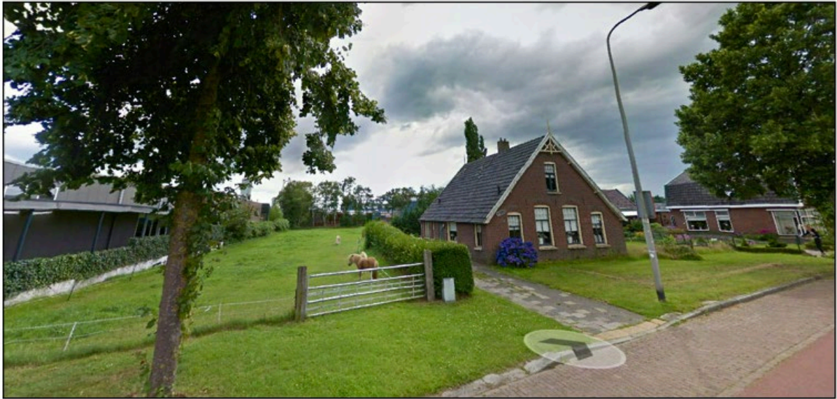
Afbeelding 2.3: Huidige situatie in het plangebied (Bron: Google Streetview)
