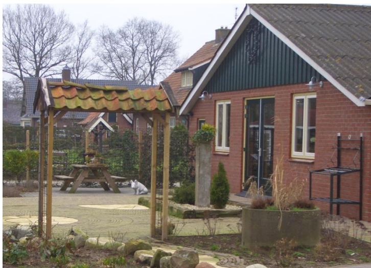
foto 3: gerenoveerd asbestdak met dakgoot (zij aanzicht koffieschenkerij)
