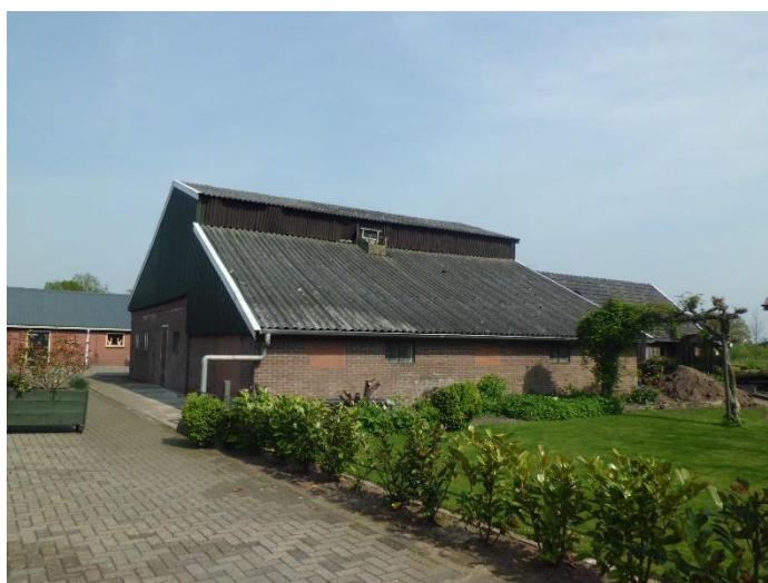
foto 1: gerenoveerd asbestdak met dakgoot
