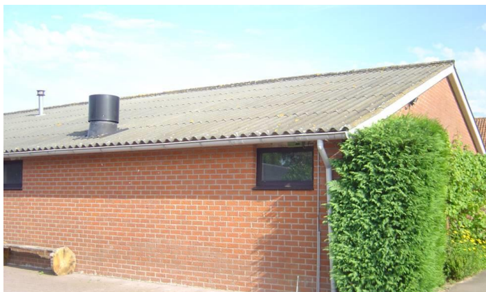
foto 2: gerenoveerd asbestdak met dakgoot (vm. stal)
