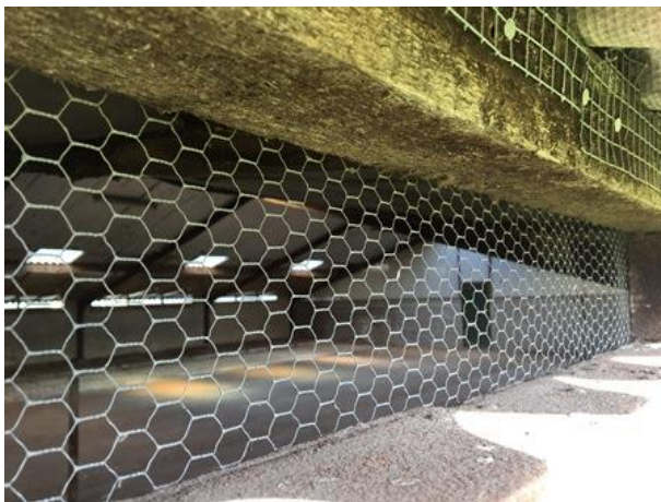
Afgedichte openingen om te voorkomen dat vogels gaan nestelen in de stal.
