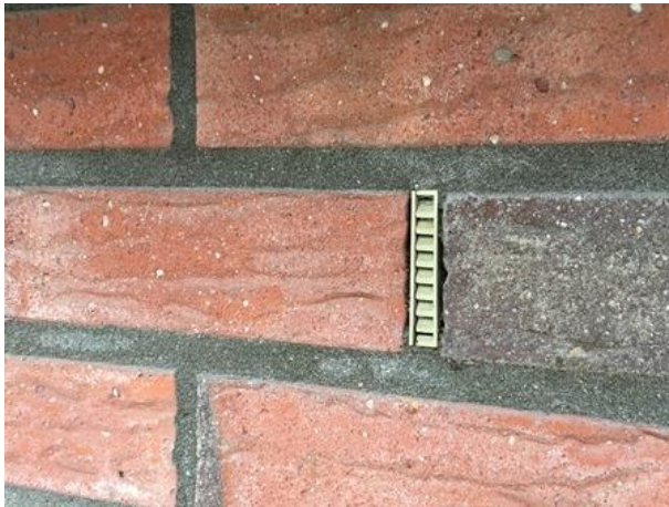
Roostertjes in de stootvoeg (1 e Meijerinkshoekweg). Een dergelijk roost voorkomt dat vleermuizen de spouw kunnen betreden.
