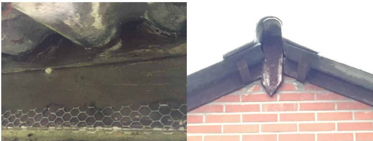
Door gaten af te dichten, wordt voorkomen dat vogels in de gebouwen geen nestelen.
