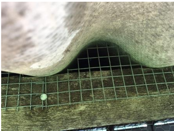
Afgedichte openingen om te voorkomen dat grondgebonden zoogdieren, zoals de steenmarter, een verblijfplaats bezetten in de gebouwen.
