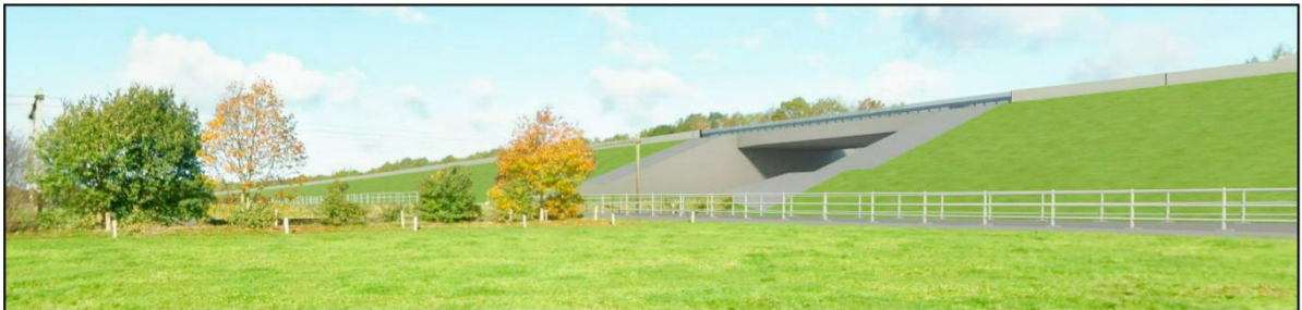
Afbeelding 2.7 Maaiveldzicht op de fietstunnel ten hoogte van de spoorlijn (Bron Rijkswaterstaat)
