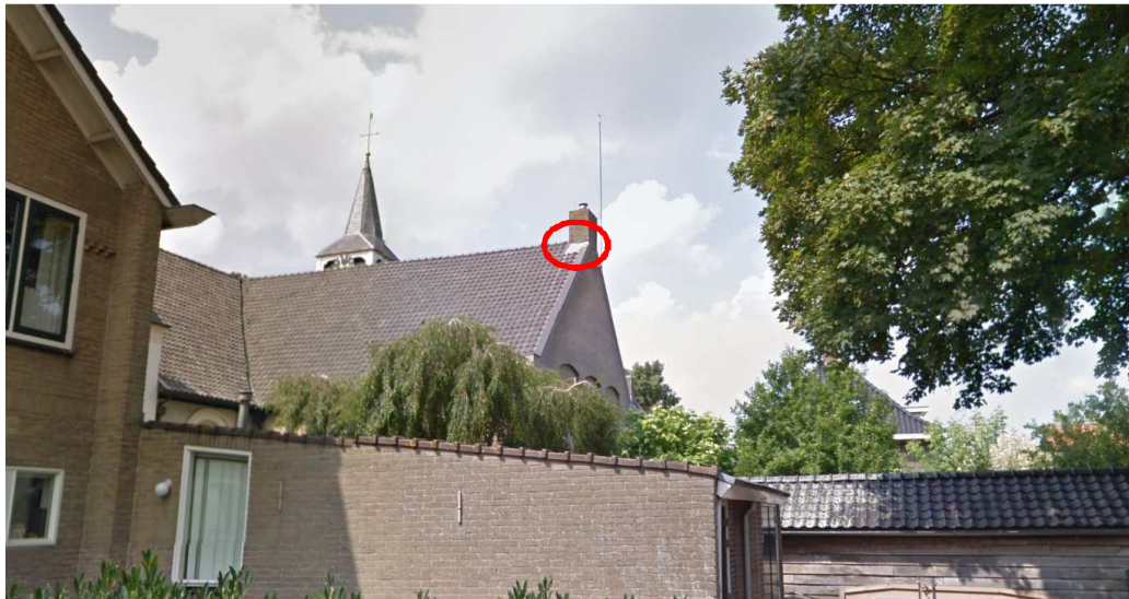
Invliegopening van vleermuizen in de het kerkgebouw.
