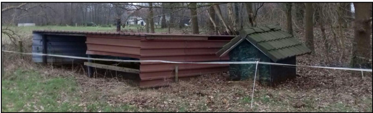
Afbeelding 2.6: Landschapsontsierende bebouwing op agrarische cultuurgrond aan de Kremersweg ongenummerd in Enter (Bron: Google Streetview, 2009)
