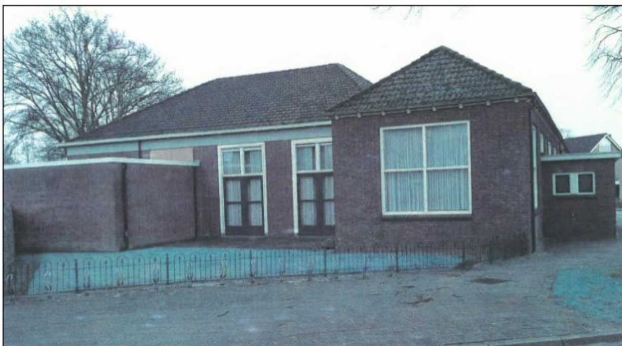
Afbeelding 2.4 Zijaanzicht linkerzijgevel van het hervormd dienstgebouw (Bron: onbekend)
