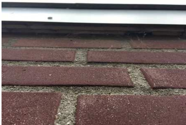
Boeiboord aan het gebouw. Deze is strak tegen de betimmering bevestigd en biedt vleermuizen geen kans om er een verblijfplaats achter te bezetten.
