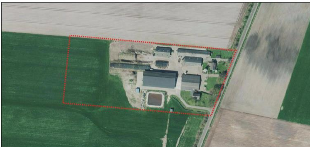
Figuur 2.7 Luchtfoto van de Vossenbosweg 3a (Bron: Provincie Overijssel)
