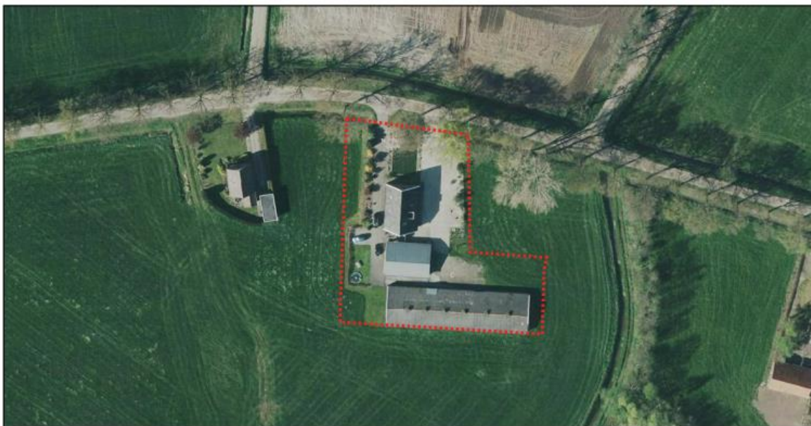
Figuur 2.5 Luchtfoto van de Morslaan 14 (Bron: Provincie Overijssel)
