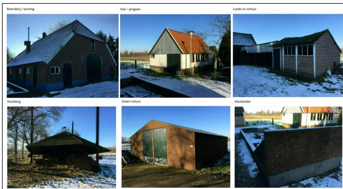
Figuur 2.2 Foto's huidige situatie (Bron: initiatiefnemer)
