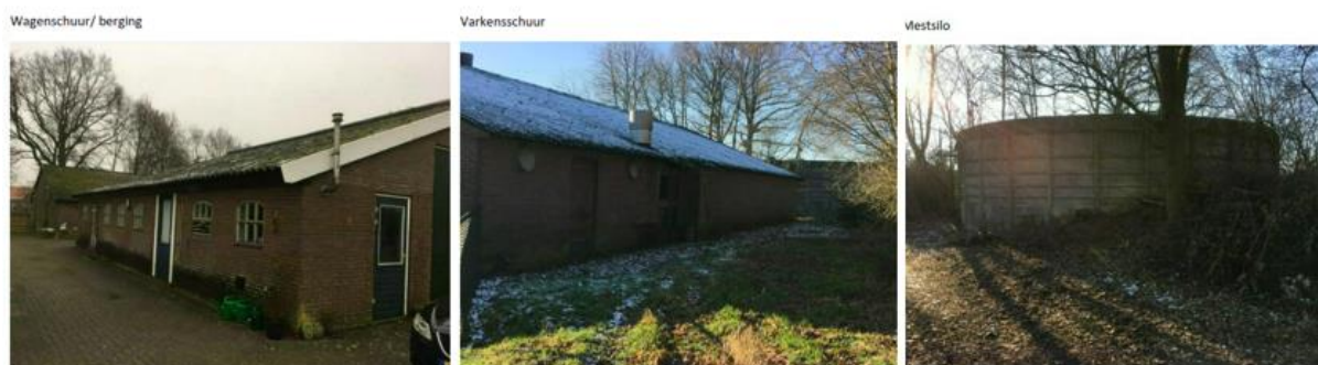
Figuur 2.4 Foto's huidige situatie (Bron: initiatiefnemer)
