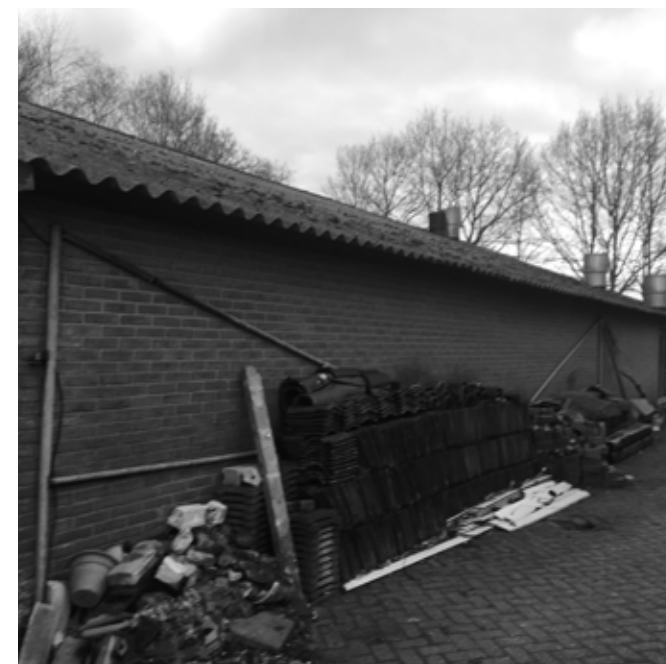
landschapsontsierende bebouwing wordt gesloopt
