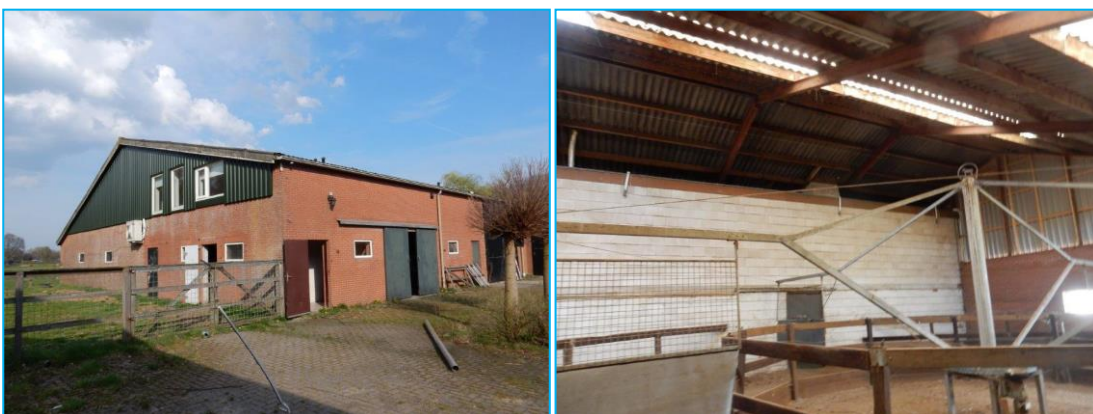
Foto's: Indrukken plangebied. De te amoveren opstallen.
