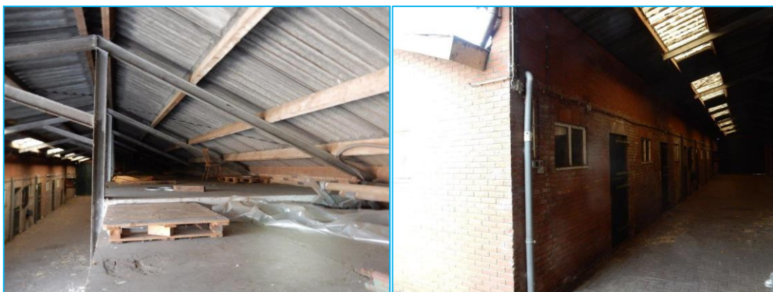
Foto's: Indrukken plangebied. De te amoveren opstallen.
