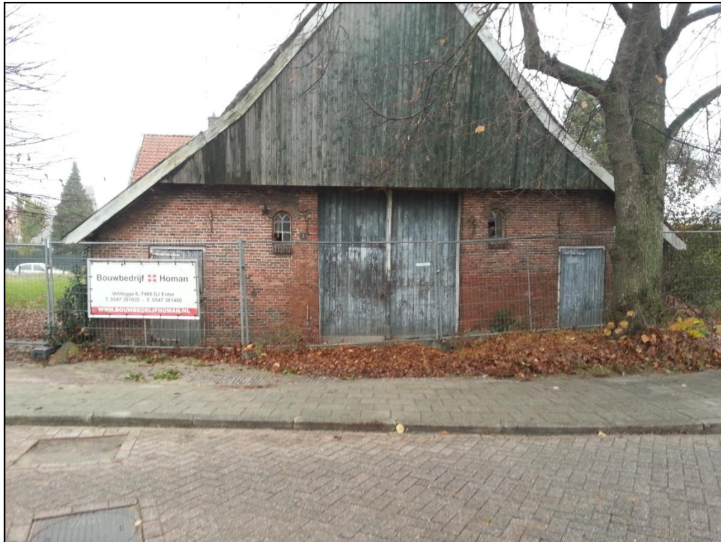
Afbeelding 5. Achtergevel van het nog bestaande huis met aan de muurankers het jaartal 1791.
