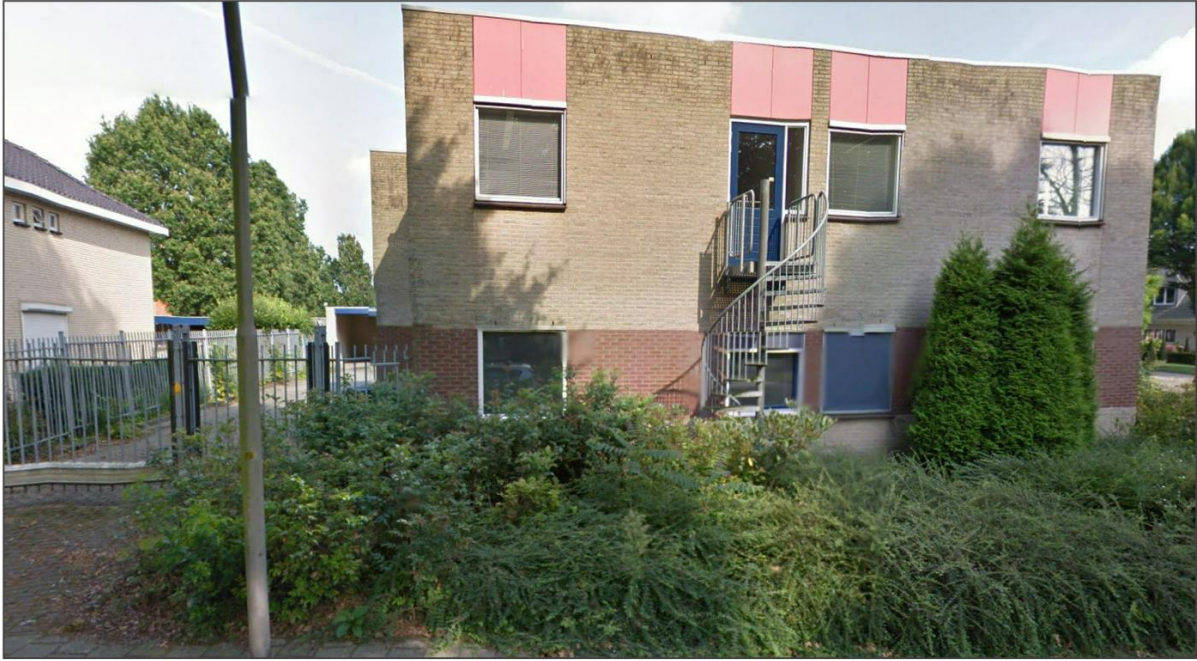
Afbeelding 2.3 Foto's van de bestaande situatie aan de zuid- en westzijde van het plangebied (Bron: Google Street View)
