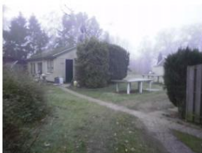
te slopen opstal 03
