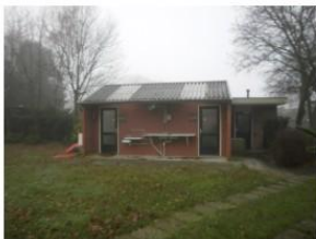
te slopen opstal 02
