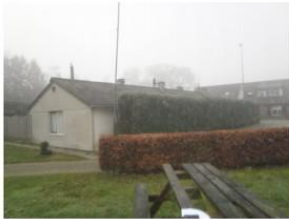
te slopen opstal 01
