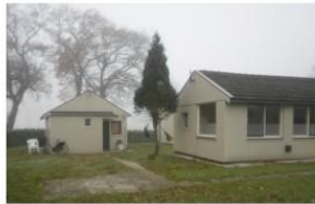
te slopen opstal 05
