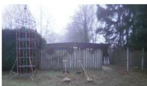
te slopen opstal 04
