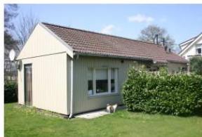
te slopen opstal 08
