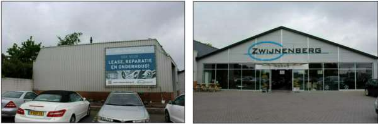
Figuur 5.4: Bestaande gevelbeplatingen showroom en werkplaats
