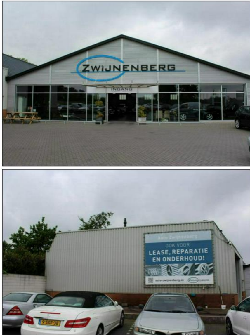
Afbeelding 3.3 Bestaande gevelbeplatingen showroom en werkplaats
