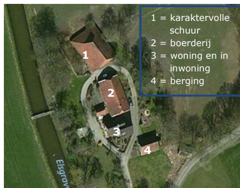
Figuur 2.2: Luchtfoto met bebouwing op het perceel (bron: Bing maps)
