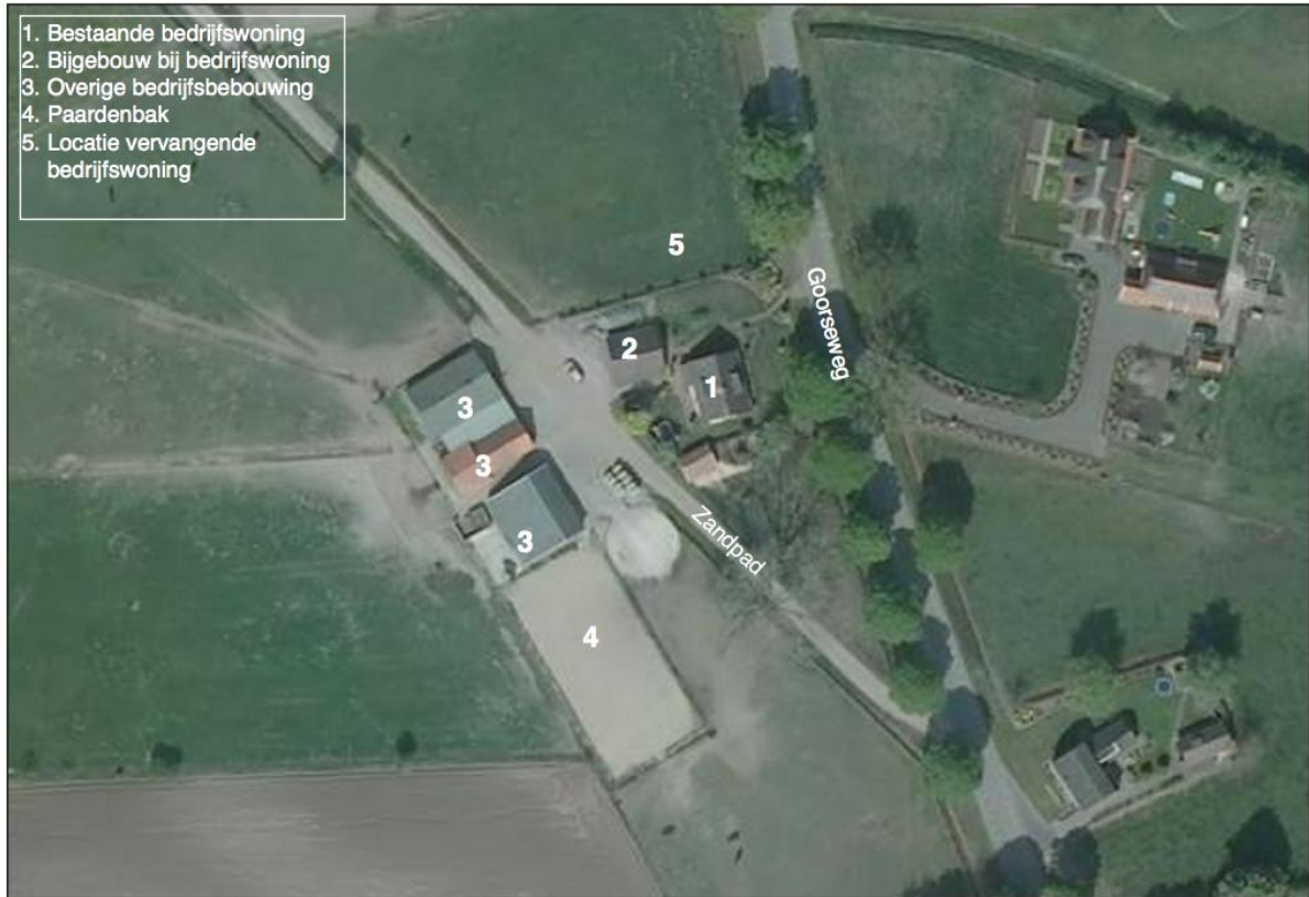
Figuur 2.3: Bebouwing plangebied (Bron: provincie Overijssel)
