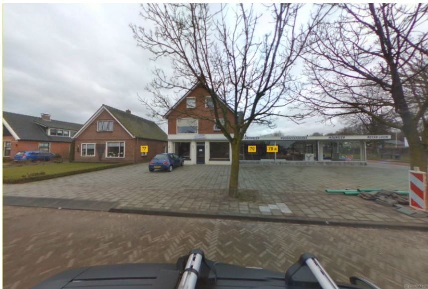
figuur 5: foto voorgevels 1 e Esweg 77 en 79 (incl. winkelruimte) bron: Cyclorama
