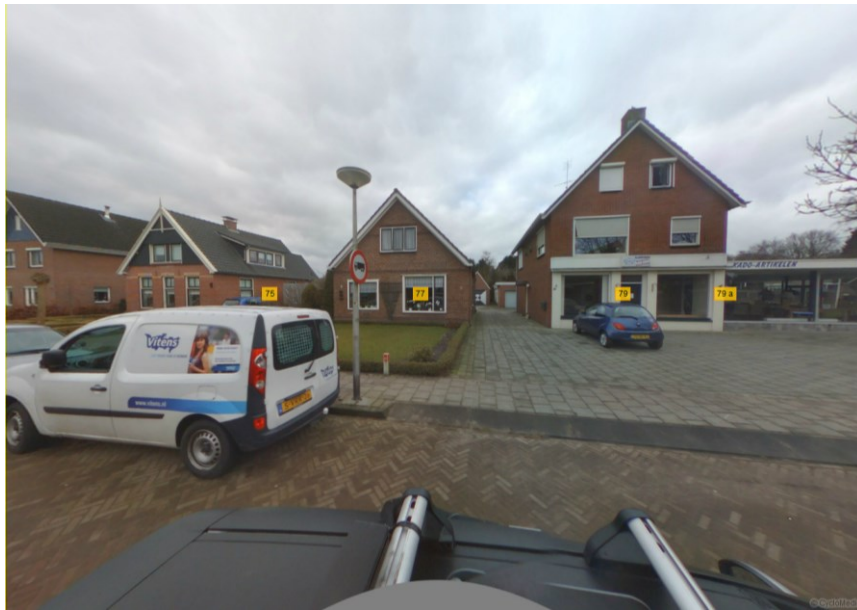
figuur 4: foto voorgevels 1 e Esweg 75, 77 & 79
