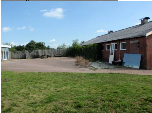
Afbeelding schuur met asbest verdacht dak:
