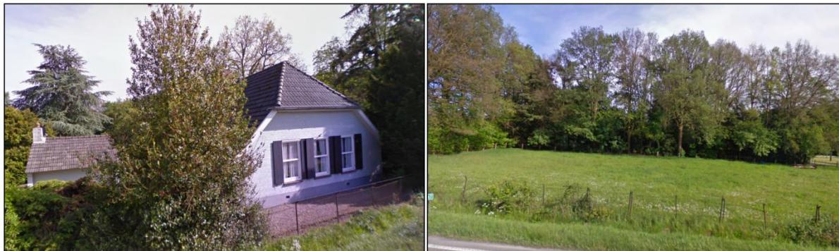
Figuur 2.3: Straatbeelden plangebied vanaf de Rijssensestraat (Bron: Google Streetview)
