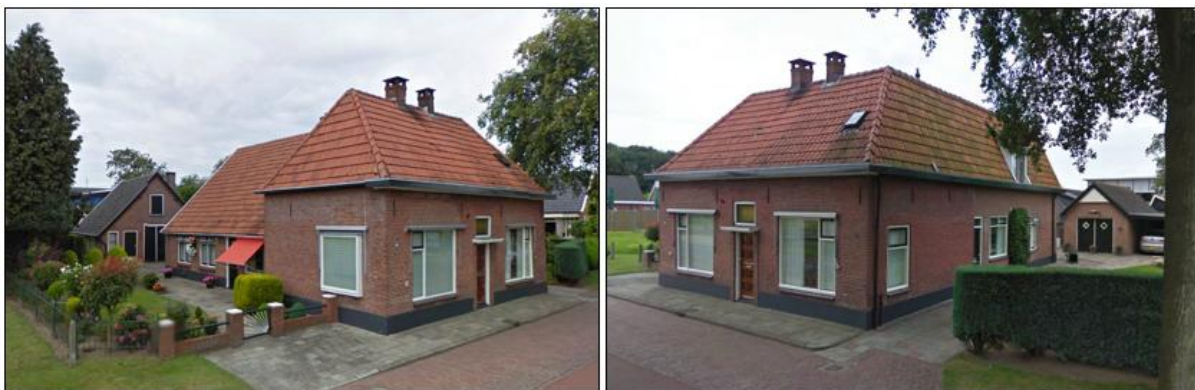
Figuur 2.2 Straatbeelden van huidige situatie in het plangebied (Bron: Google Streetview)
