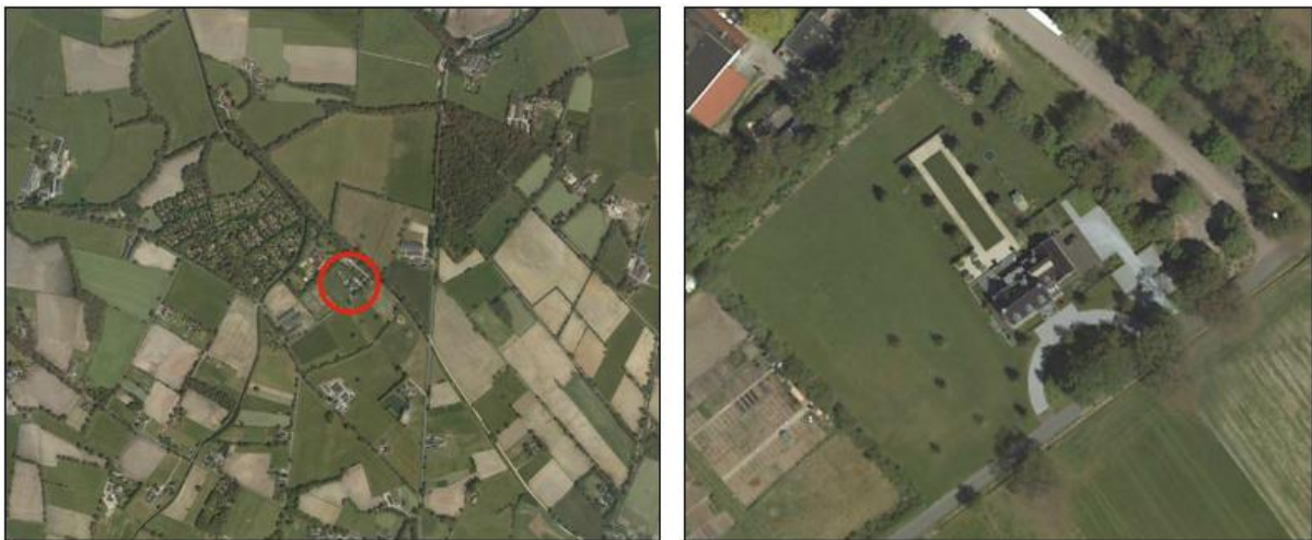
Figuur 2.2 Luchtfoto's huidige situatie plangebied (Provincie Overijssel)
