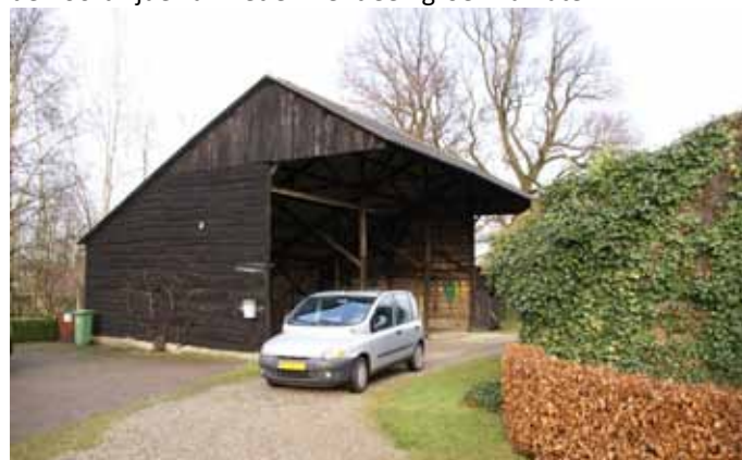
de kapschuur en het bakhuis (rechts) zal ook gesloopt worden
