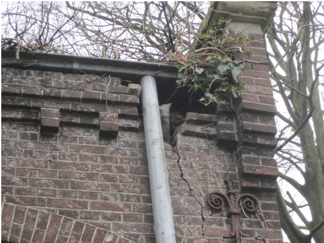
Foto 13. Opening in het exterieur van het gebouw.
