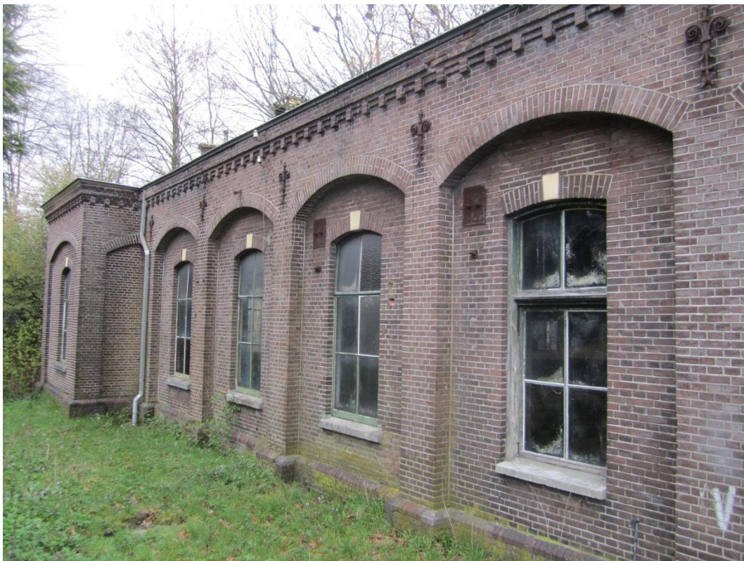
Foto 1. Het voormalige waterpompstation oostzijde.
