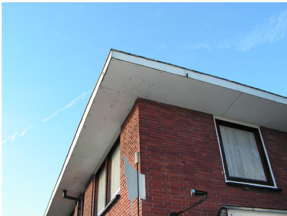
Figuur 3. De dakranden van het huis aan de Nijverdalseweg.
