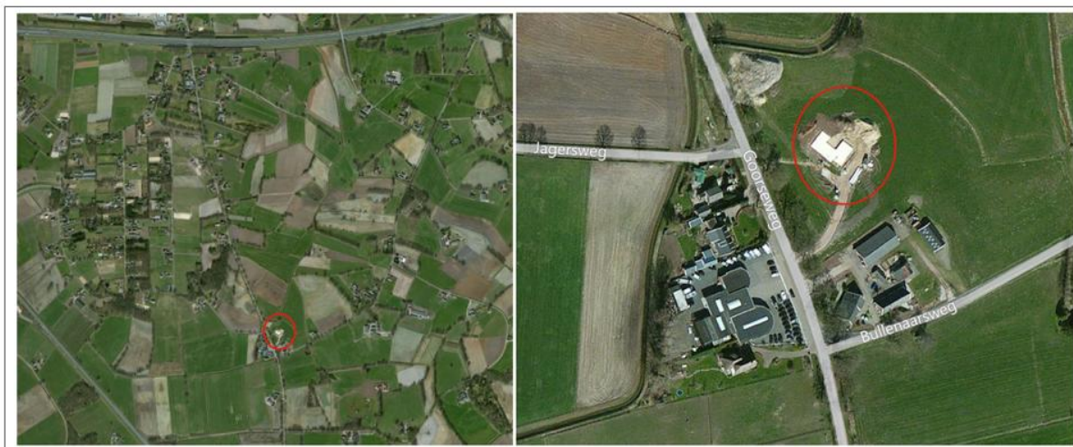
Figuur 2.2: Luchtfoto's huidige situatie plangebied (Bron: Bingmaps)
