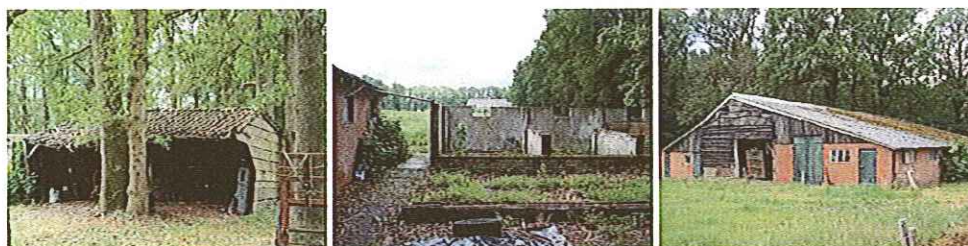
Foto's: Indruk te slopen opstallen.
