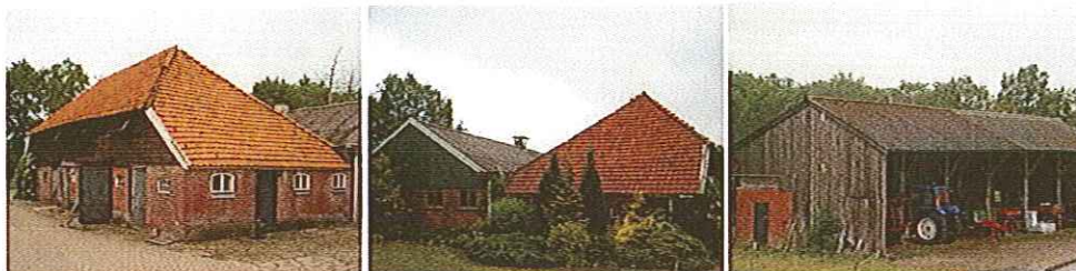
Foto's: Indrukken van de te slopen varkensstallen en de te verbouwen kapschuur.
