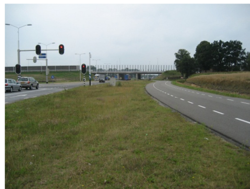
Afbeelding 2.8 De Rijssensestraat en de parallelweg langs het plangebied. Verderop het viaduct van de A35
