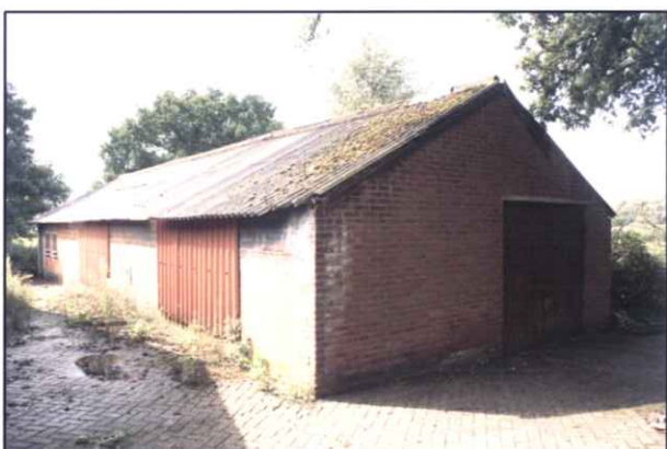
Schuur 3 – Garage / Opslag
