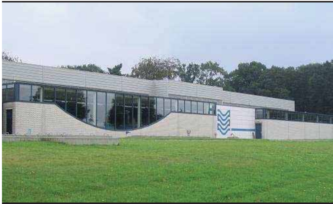
Figuur 2.17 Pompstation Wierden (met waterzuivering)
