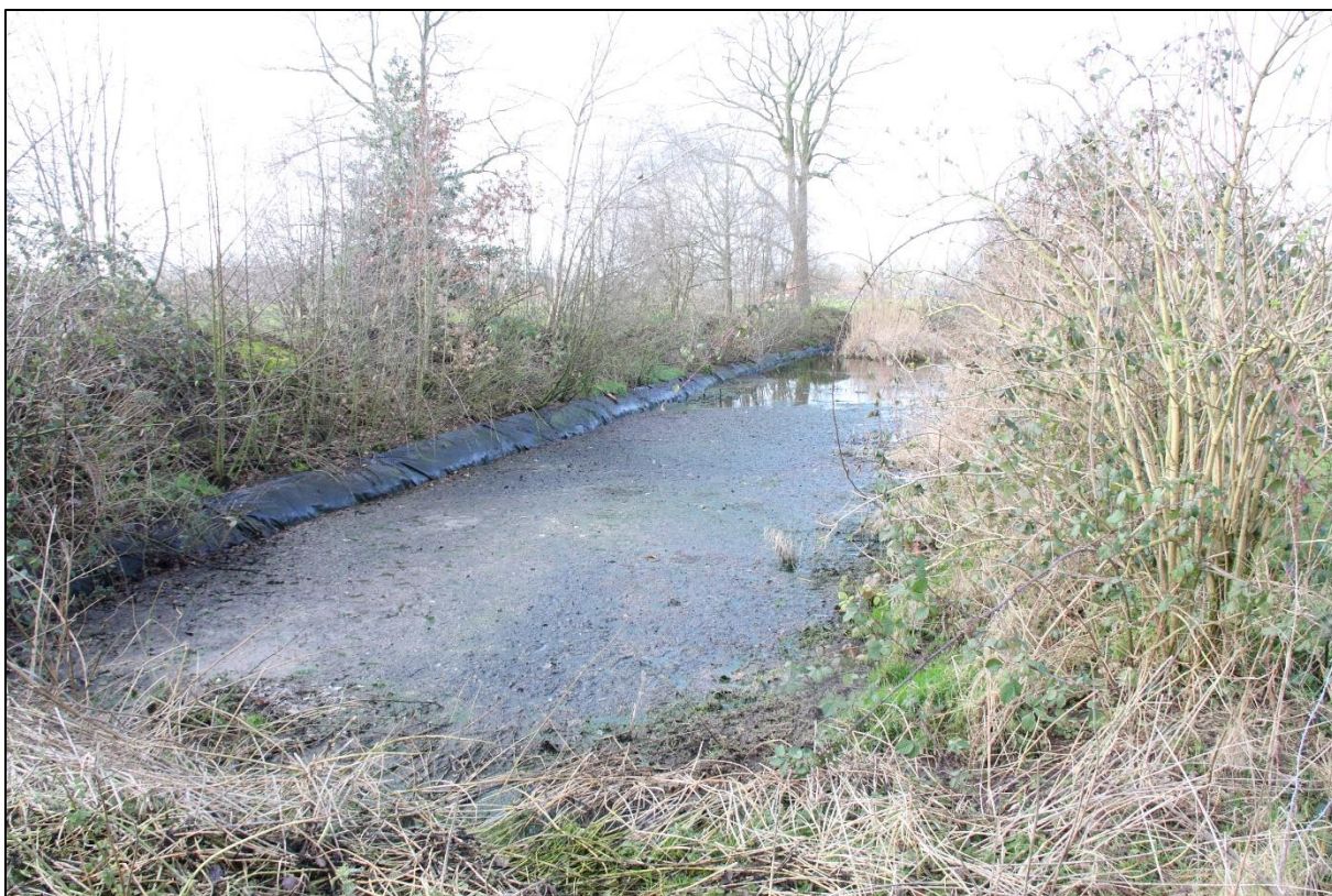
Figuur 9. Aan de zuidzijde van het filter gelegen bezinkbassin
