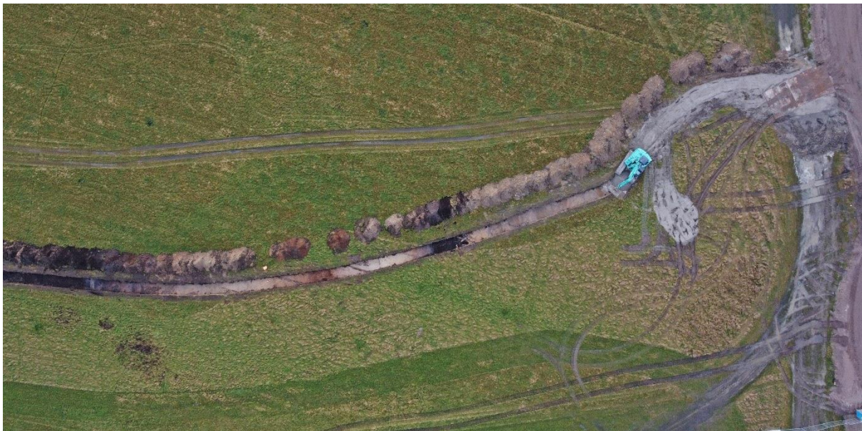
Figuur 10. Droneopname van de aanleg van het leidingcunet op de overgang van deelgebied 3 en deelgebied 4.
