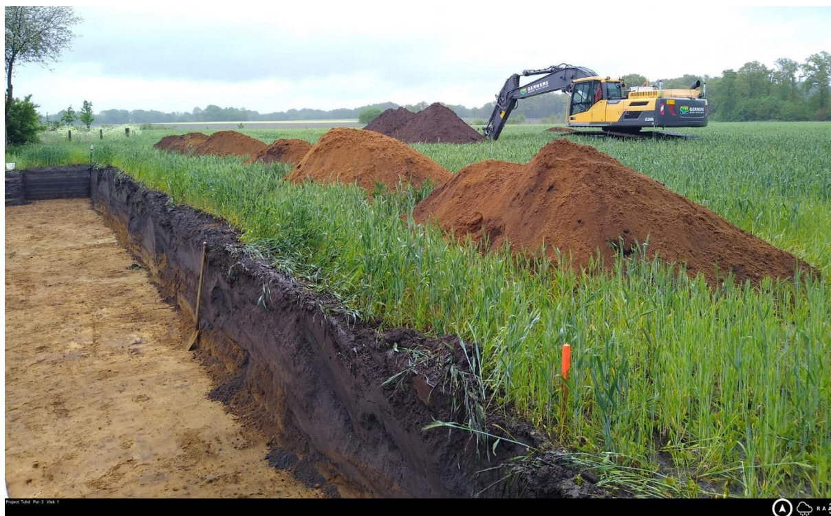
Figuur 7. De aanleg van proefsleuf 2 op de voorgrond werkput 1.
