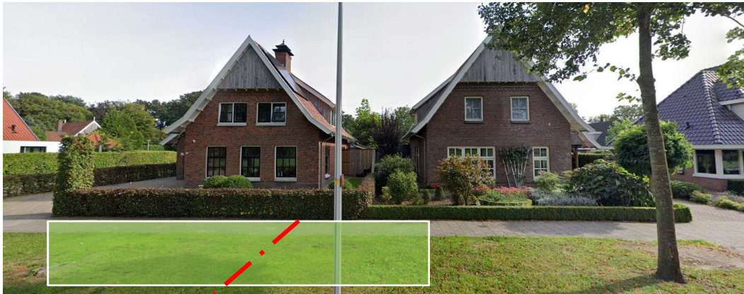
Afb. 4 – Situatie woningnummer 20 (links) en 18 (rechts) op september 2021. De rode hartlijn toont bij benadering de middellijn van de ontsluitingsweg zijde Kottinkamp.
