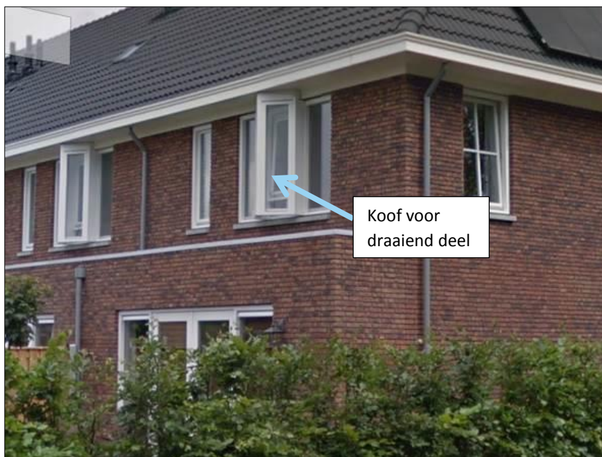
Figuur 6 Voorbeeld van een koof voor kozijn met te openen delen om het geluidsniveau te verlagen.
