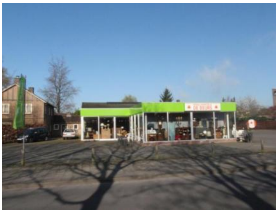
Foto 1. Te slopen kringloopwinkel 'De beurs'
