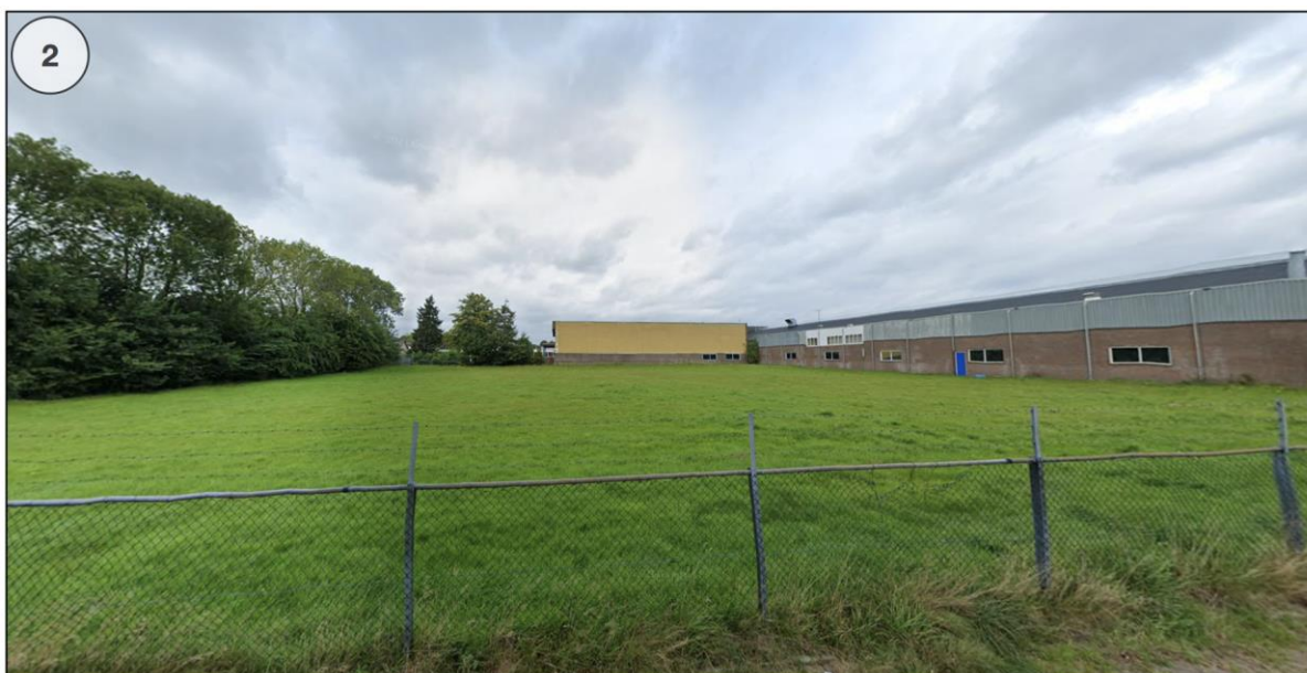
Afbeelding 5 Straatbeeld 2 (Bron: google streetview - september 2021)
