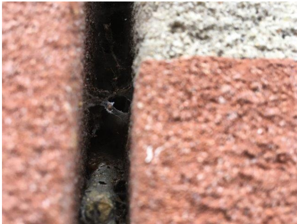
Openstootvoeg met spinrag. De dikke laag spinrag vormt een aanwijzing dat vleermuizen de openingen niet benutten als invliegopening.
